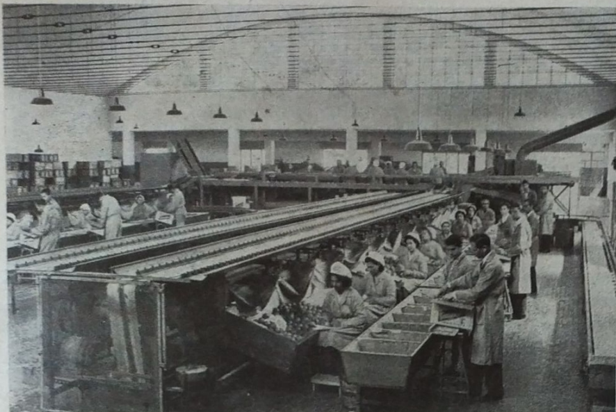
Spazzolatura, asciugatura e selezione su nastro degli agrumi siciliani, presso la SACOS di Bagheria
