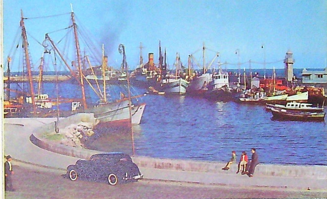
Un aspect partiel du môle de Sta. Cruz de Tenerife, abrité des vents.
