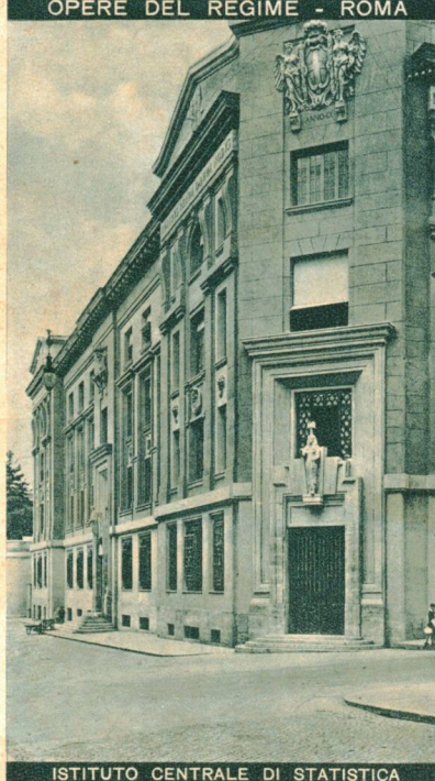
ISTITUTO CENTRALE DI STATISTICA
