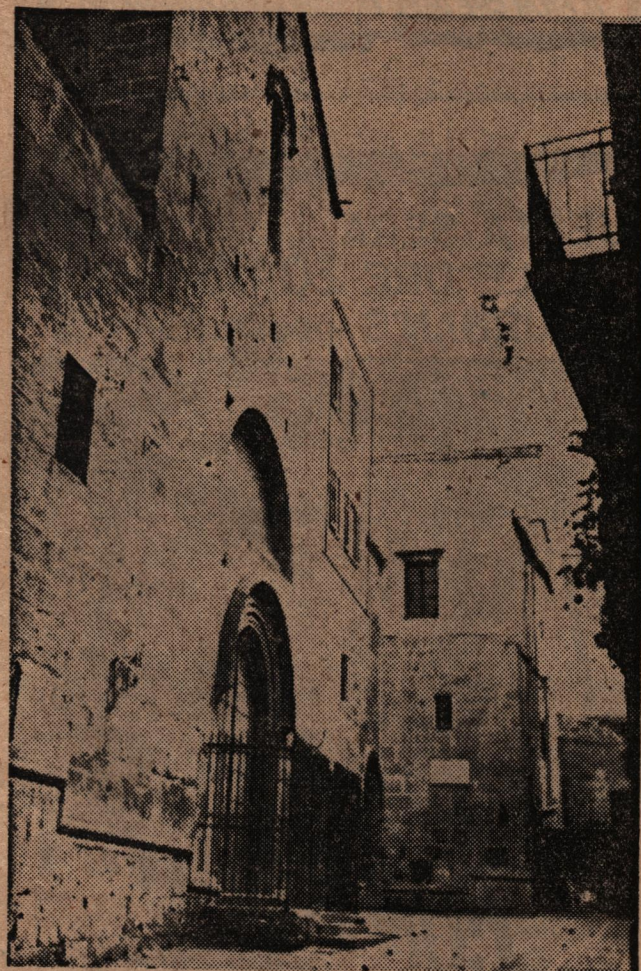
Il deturpato prospetto della chiesa della Gancia
