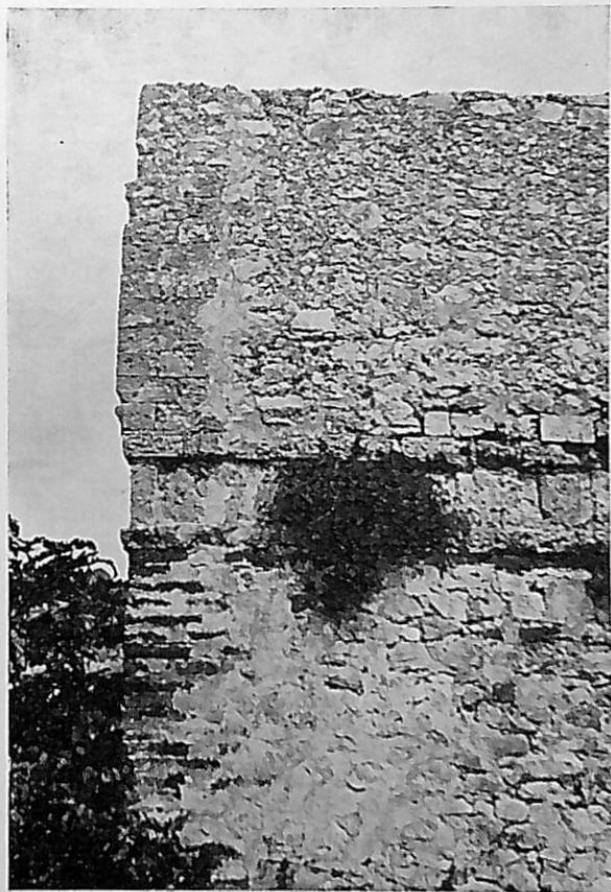
Fig. 8 - Esterno: muro con spigoli in mattoni sesquipedali e fascia in tufo
