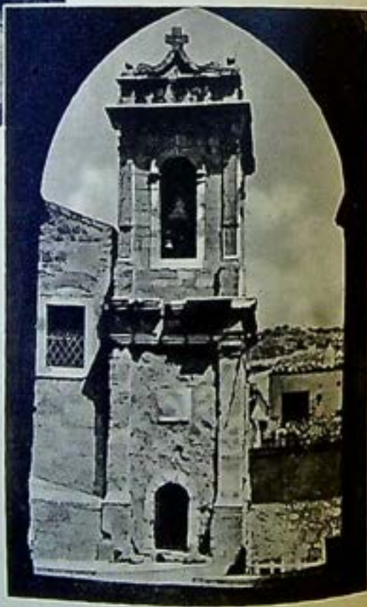
PETRALIA SOTTANA: IL CAMPANILE DEI BIANCHI, VISTO ATTRAVERSO L'ARCO DEL CAMPANILE DELLA CHIESA MADRE.
