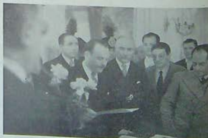
1. Gennaio 1948: la consegna della Carta Costituzionale ai Prefetti dell'Isola. Alessi lancia, in quella occasione, un messaggio alle popolazioni siciliane annunciando una vasta e concreta politica di ricostruzione. La Regione è ora impegnata nella costruzione delle case per i lavoratori.
