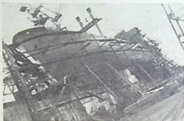
Il « Bangor Bay » era in corso di riparazione nel Cantiere allorché gli impiegati abbandonarono gli uffici. Il lavoro, intorno alla nave, sotto gli occhi degli stranieri, divenne febbrile, avendo la Commissione interna confermato l'impegno di consegna assunto dalla Direzione. Gli ufficiali stranieri seguivano con simpatia la febbrile attività degli operai ai quali distribuivano sigarette. La storia del « Bangor Bay » servì di spunto a più di un giornalista per inviare brillanti, anche se non sempre fedeli, corrispondenze al nord.
